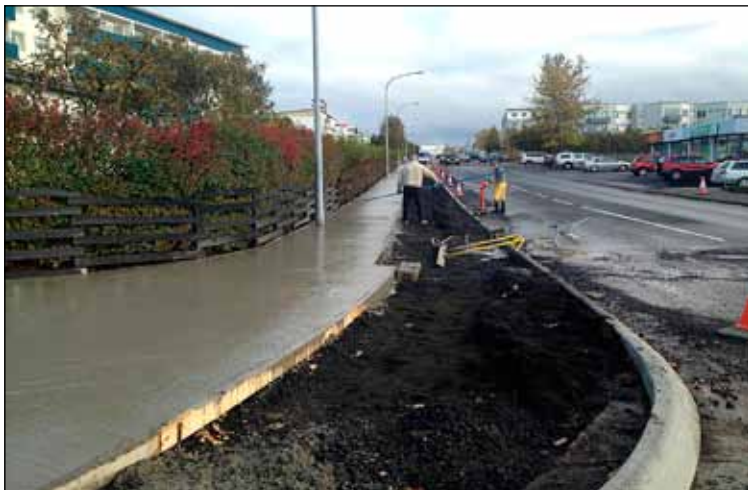
Unnið við lagningu göngustíga við Hagamel.
