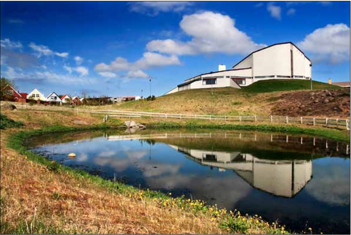
Fella- og Hólakirkja stendur í útjaðri Fellahverfis. Í upphfi var gert ráð fyrir að tvær kirkjur risu í Breiðholti III. Fellakirkja á þeim stað sem Fella- og Hólakirkja stendur í dag en Hólakirkja þar sem þriðju hluti Hólagarðs er nú. Hætt var við þessi áform og í stað þeirra byggð ein kirkja fyrir Fella- og Hólahverfi. Mynd: Guðmundur Hafsteisson.
