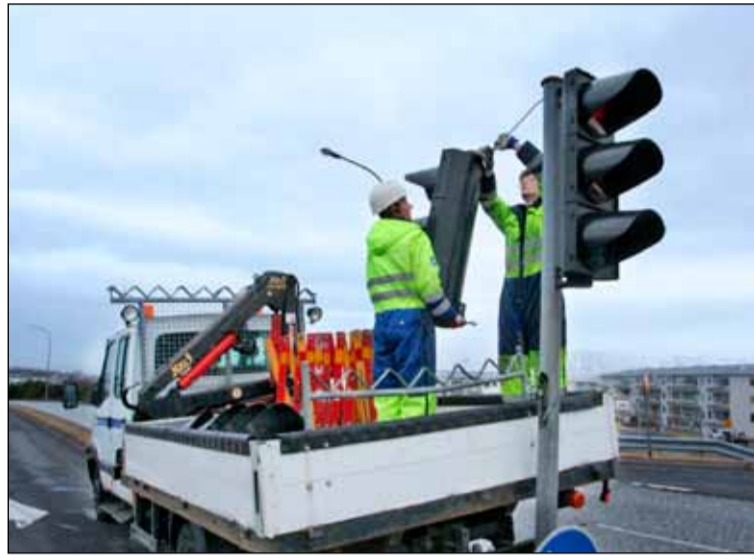
Unnið við uppsetningu hinna nýju umferðarljósa.
