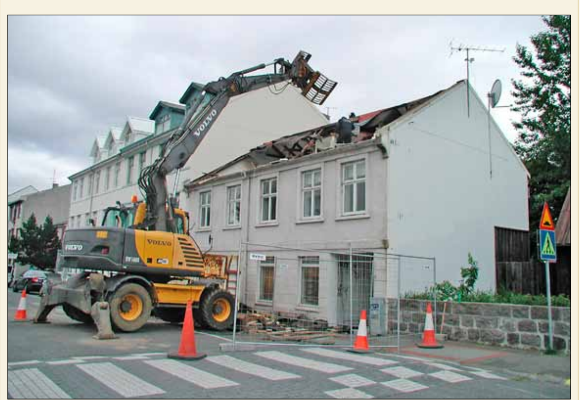
Nei – það er ekki verið að rífa Garðastræti 21 heldur aðeins að taka þakið af því. Húsið var selt og ætlað nýr eigandi þess að hækka það um eina hæð auk gagnberra endurbóta en það er fremur illa farið.
