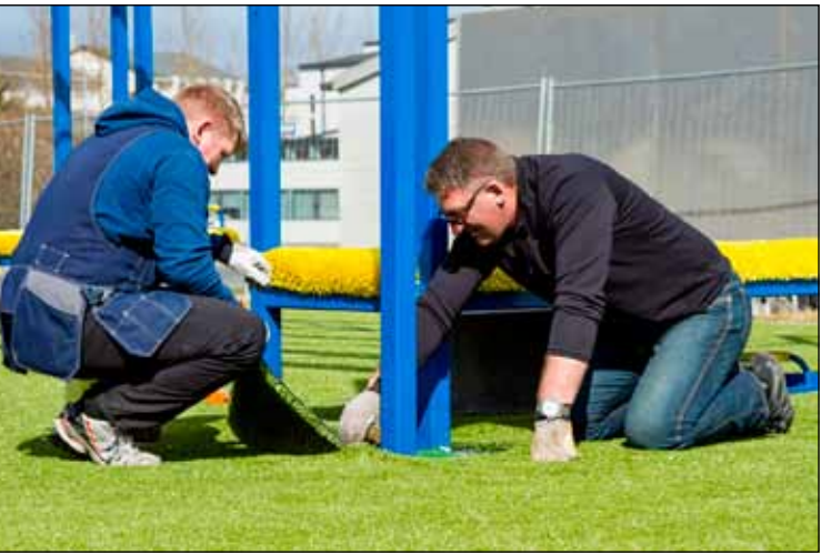
Unnið við lokafrágang hreystibrautarinnar.
