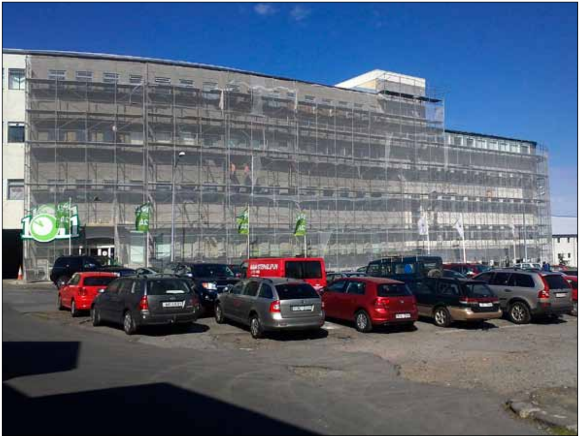
Vesturhluti Héðinsreitsins og Héðinshúsið í baksýn. Eins og sjá má er reiturinn notaður fyrir bílastæði. Gamalt malbið er víða brotið upp og reiturinn nánast búinn malarslitlagi.
