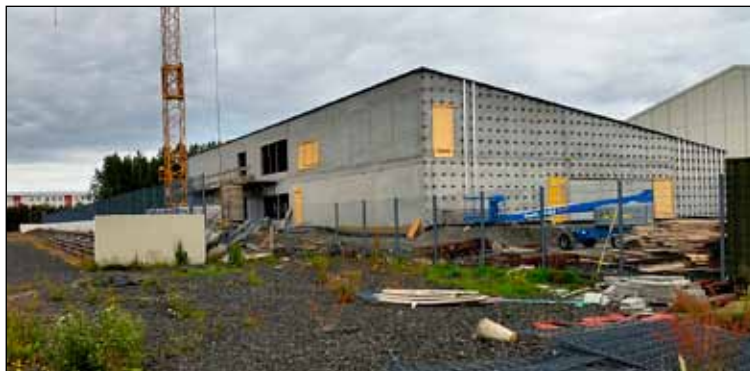
Húsnæði World Class við Austurberg er enn á byggingarstigi hálfu ári eftir að áformað var að opna stöðina.
