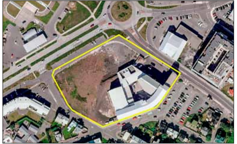
Talsvert landrými er á hinu óbyggða svæði Héðinsreitar vestan Héðinshússins.
