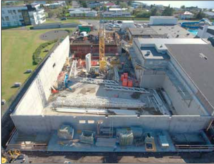
Mynd af framkvæmdum við fimleikahúsið tekin úr dróna nýlega.
