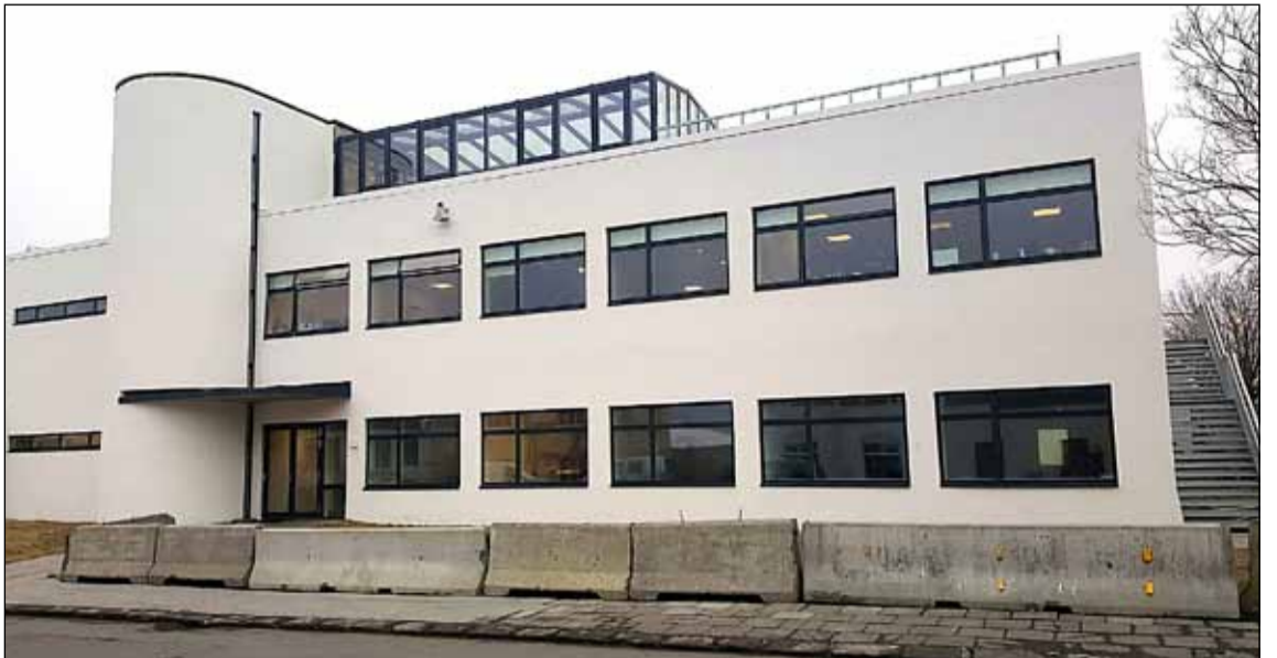
Nýbygging Vesturbæjarskóla við Framnesveg.
