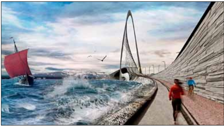
Tölvugerð mynd Guðjóns Erlendssonar arkitekts sem sýnir brú yfir Skerjafjörð. Skerjabrautin yrði að langmestu leyti á uppfillingum og um helmingi styttri en Gilsfjarðarbrúin.
