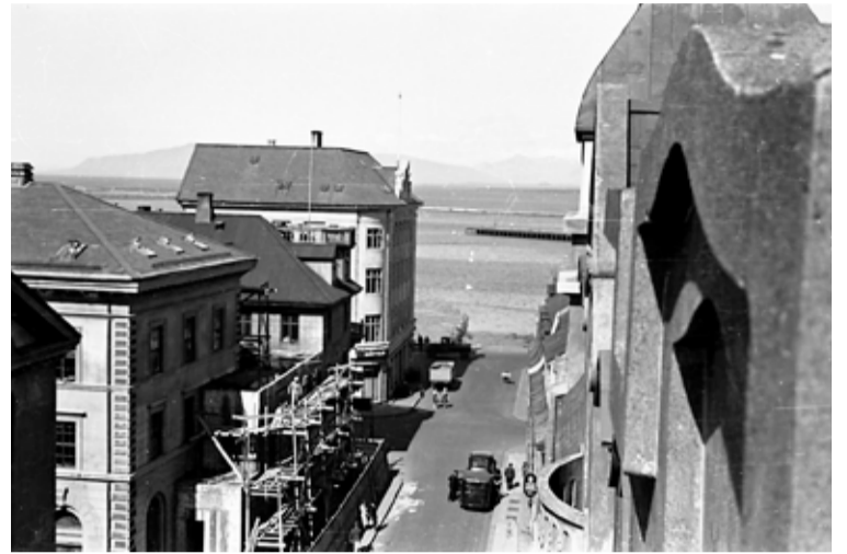
Þessi mynd er tekin norður Pósthússtrætið á fjórða áratugnum líklega af Sigurði Ólafssyni og sýnir þegar unnið var að viðbyggingu við Landsbankahúsið
