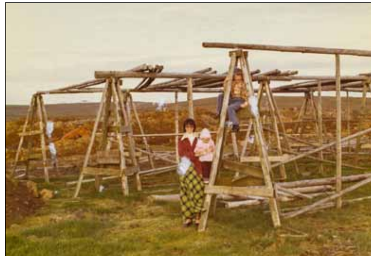
Gamli fiskihjallar voru á lóðinni þegar Daði hóf að byggja. Síðar kom í ljós að lóðin var staðsett í Kópavogi.
