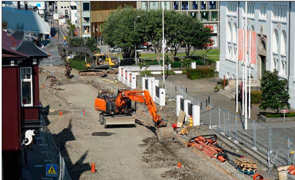
Unnið að uppfyllingu á Hverfisgötu.
