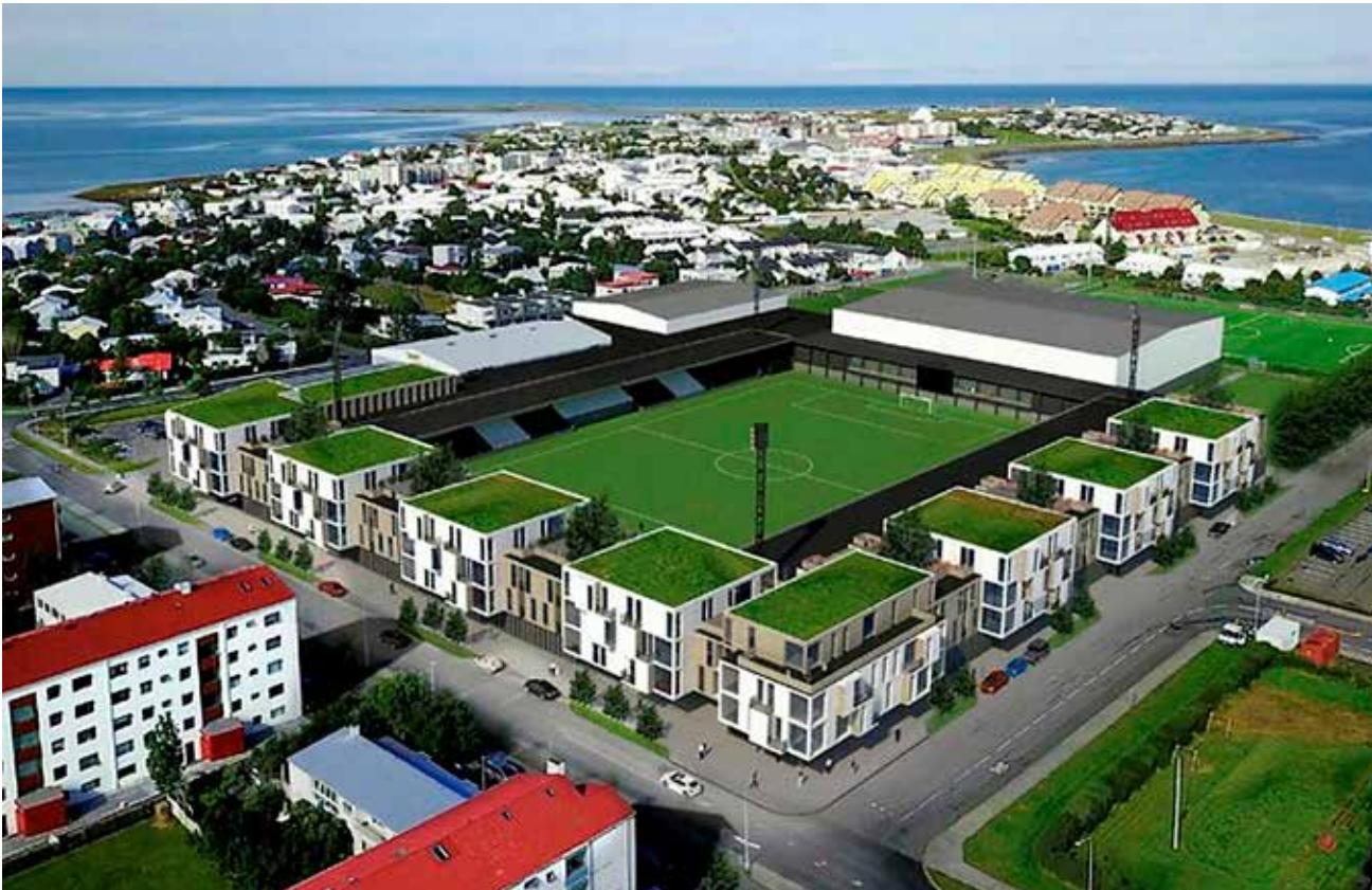
KR svæðið eins og það mun líta út eftir uppbyggingu.
